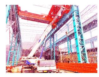
熟悉图纸及作业指导书,确保行车吊装顺利进行。 从开工至今,全体作业人员克服了作业空间有限、 多方施工交叉作业、停电等多重困难,严格按施工 方案有序进行。高空和地面作业人员上下呼应,步 调一致,默契配合,保证了吕梁建龙炼钢厂三台210t 铸吊的安全、有序安装。
